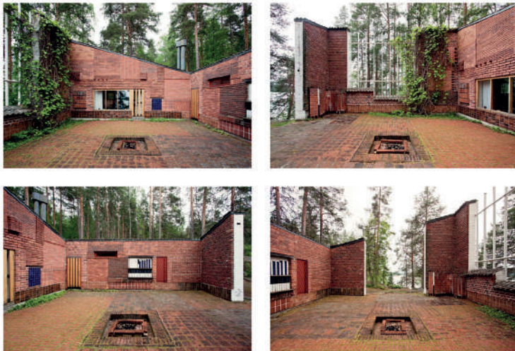
Figura 20a, b, c, d. Fotografías desde los cuatro lados del patio donde se aprecia el trazado de los pavimentos cerámicos y de los revestimientos de ladrillo de los muros. En ellos se puede observar los cambios de finalidad de cada ámbito o patio. Casa Experimental de Vocaciones en Muuratsalo (1952-1954). Alvar Aalto. [Fuente: ©Fundación Alvar Aalto]
